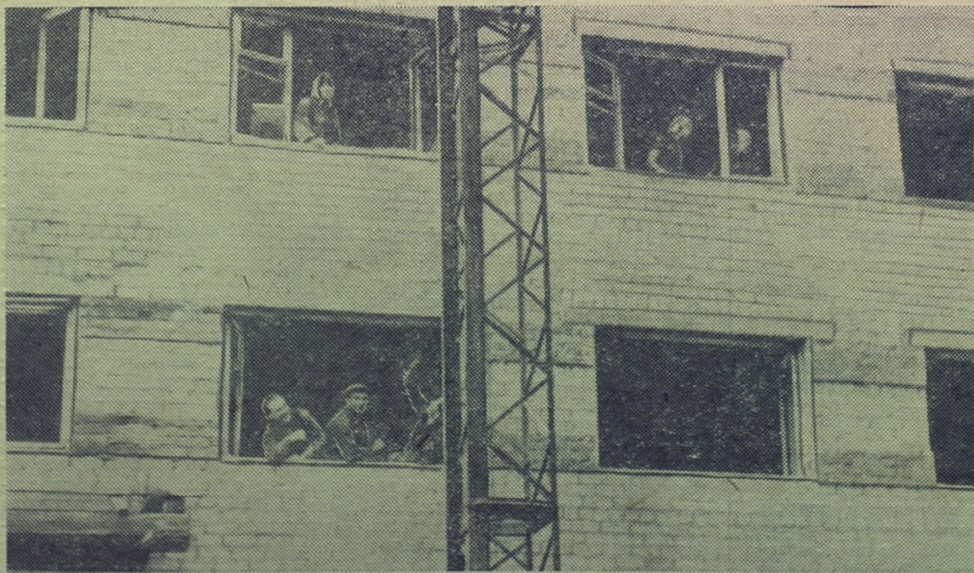
Рядом с главным зданием университета высятся светлый корпус нового строящегося общежития.
