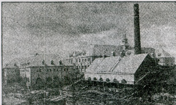
1914 г. Идет строительство комплекса на Заимке.
