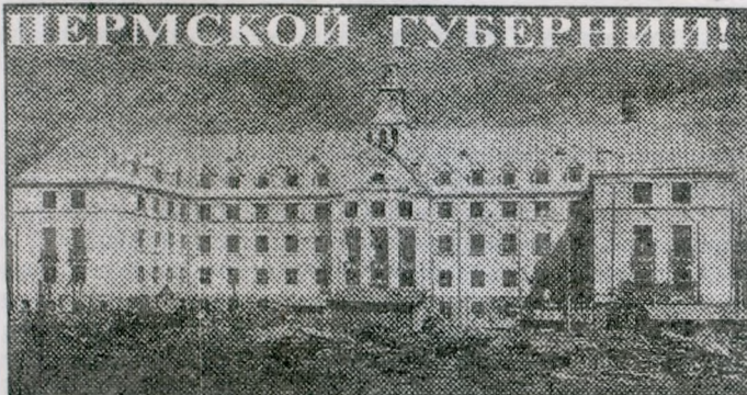
1914 г. Строительство Дома им. В.И.Мешковой.
