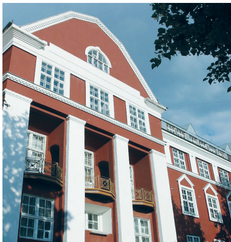
Реставрация корпуса № 2 начнется уже в этом году.
