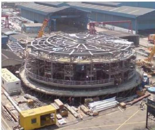
Рис. 2. Турельная система сбора на FPSO
